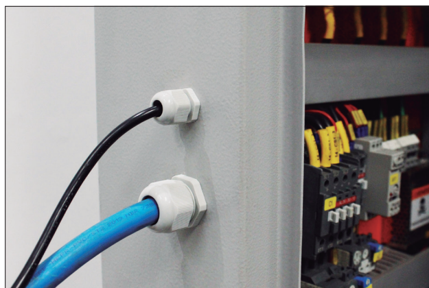
Os Prensa Cabos garantem a segurança e a integridade das conexões.
